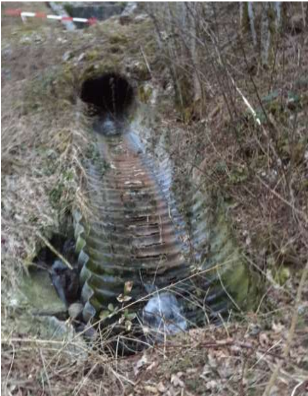
Annexe : Photos Ruz de la Praz
